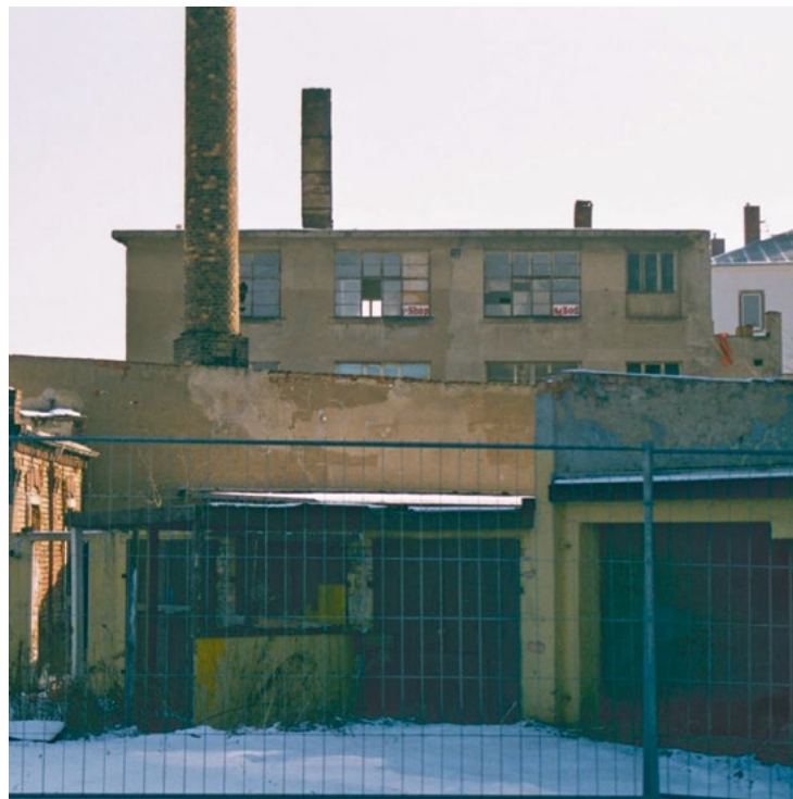
Tharandter Straße 17 vor dem Abbruch der ruinösen Gebäude im Jahr 2003 Quelle: Amt für Stadtplanung und Mobilität
