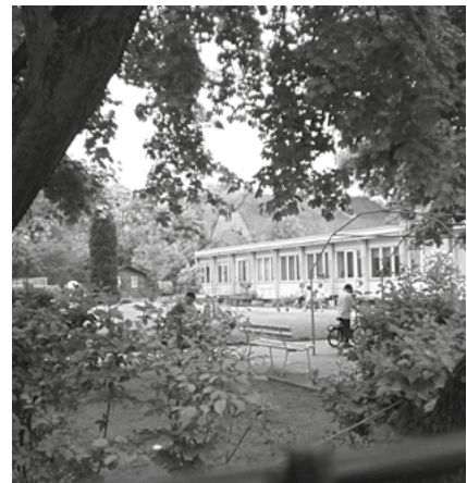
Altbau der Kita Bünastraße 30 vor dem Abriss Quelle: Amt für Stadtplanung und Mobilität
