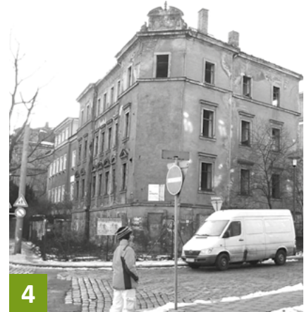
Schillingstraße 1 vor dem Abbruch im Januar 2006 Quelle: freiraumentwicklung ehrlar
