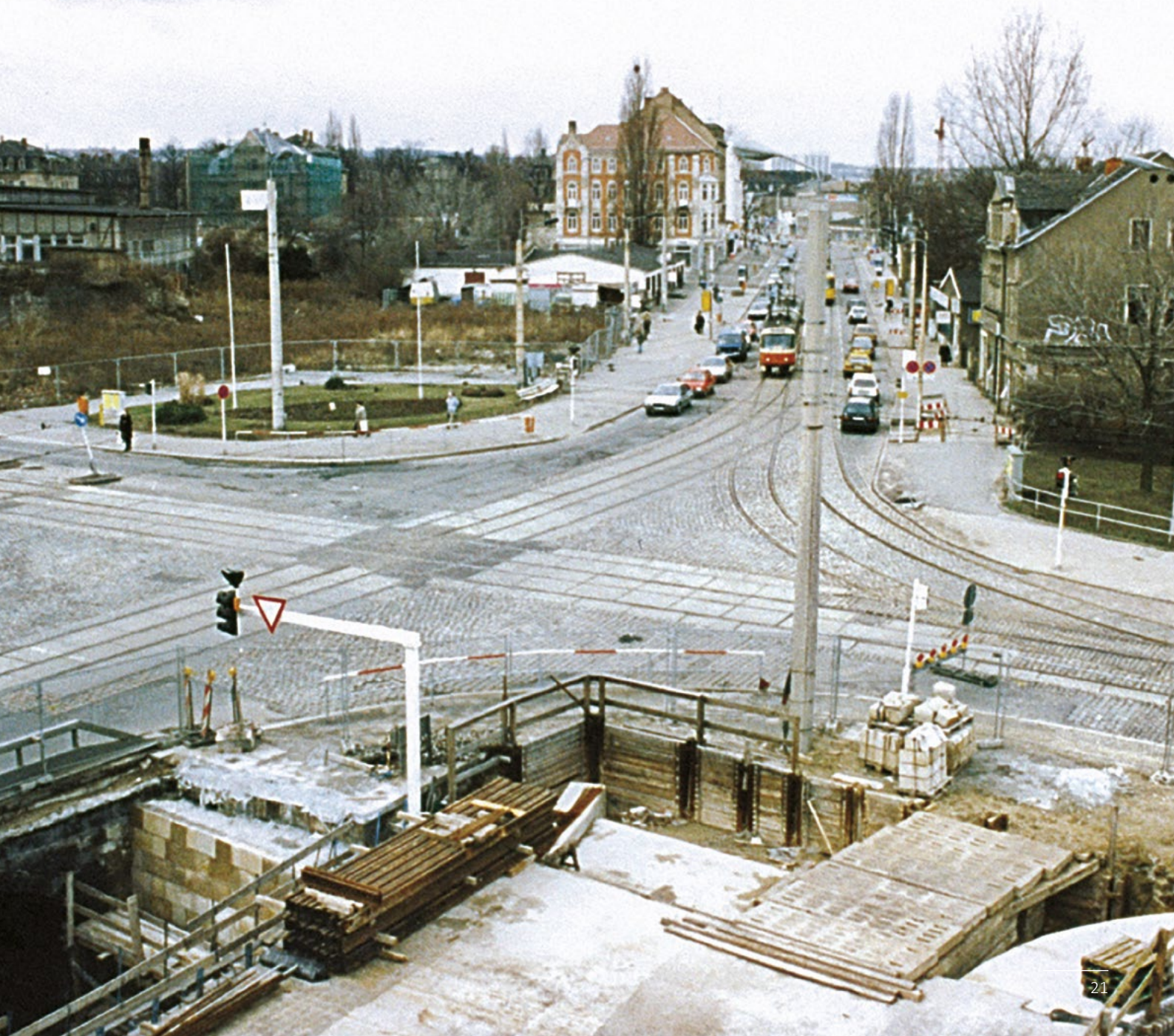
Die Kreuzung Kesseldorfer/Ecke Tharandter Straße um 1993 Quelle: Peter Bartels
