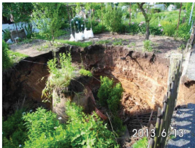
Bild 8.4: Kanalschaden im Bereich der Kleingartensparte Leuben
