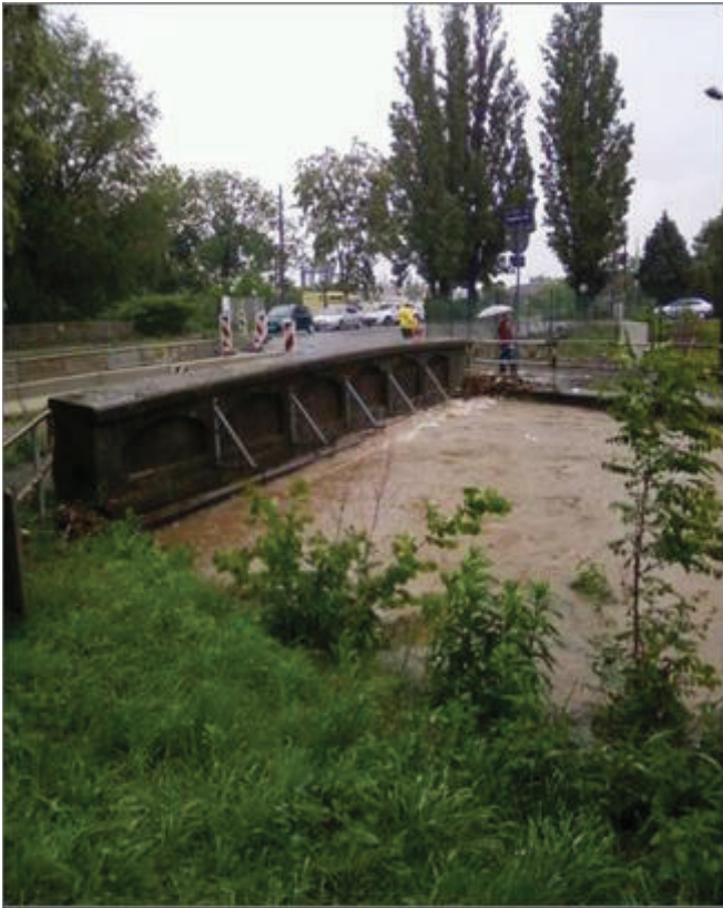
Bild 4.2: Die Brücke Prof.-Billroth-Straße ist eingestaut.
