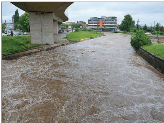
Bild 5.3: Am Weißeritzknick besteht diesmal keine Überflutungsgefahr – die Löbtauer Straße liegt deutlich höher als die Oberkante der linken Ufermauer am Knick. An der linken Seite soll künftig die Flutmulde für die Ableitung extremer Hochwasser entstehen, rechts wird die Ufermauer gestreckt.
