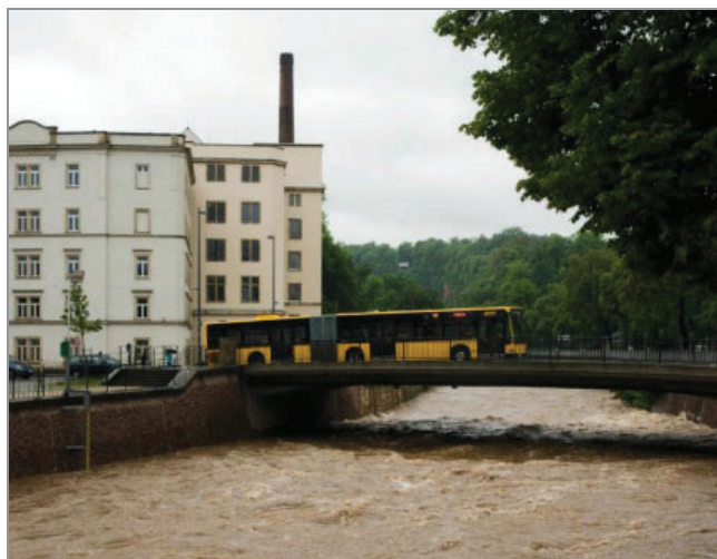
Bild 5.2: Die Brücke Altplauen ist noch nicht annähernd ausgelastet.
