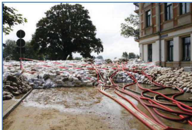
Bild 10.2.2: Sandsackverbau Scharfenberger Straße Ecke Böcklinstraße (Quelle: Hans-Günther Lindenkreuz, Stadtfeuerwehrverband)
