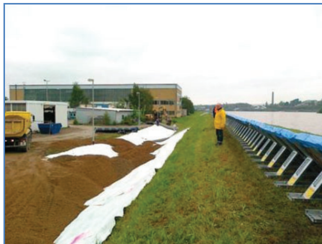
Bild 8.2: Im Bau befindlicher Auflastfilter und Aqua-Barrier am Kaditzer Deich am 3.
