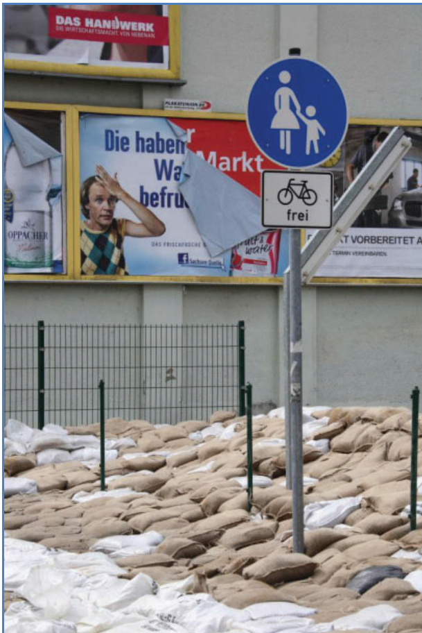
Bild 11.3: Sandsackverbau durch Bürger in einem vielfachen des eigentlich benötigten Umfangs (Quelle: Brand- und Katastrophenschutzamt der Landeshauptstadt Dresden)
