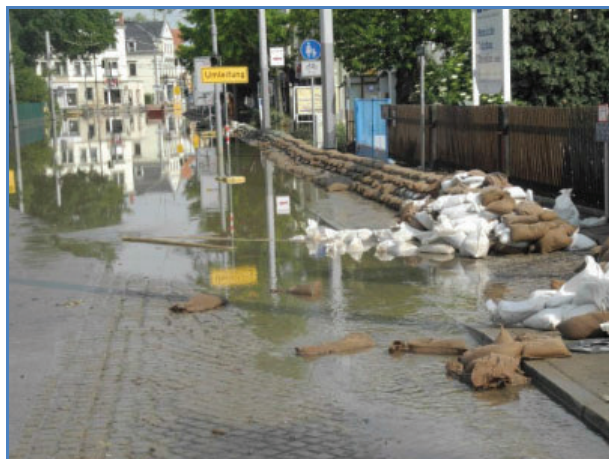
Bild 9.4: Situation Österreicher Straße nach dem Hochwasser am 08. Juni 2013. Mit dem Verbau konnte kein ausreichender Hochwasserschutz hergestellt werden (Quelle: Umweltamt der Landeshauptstadt Dresden)
