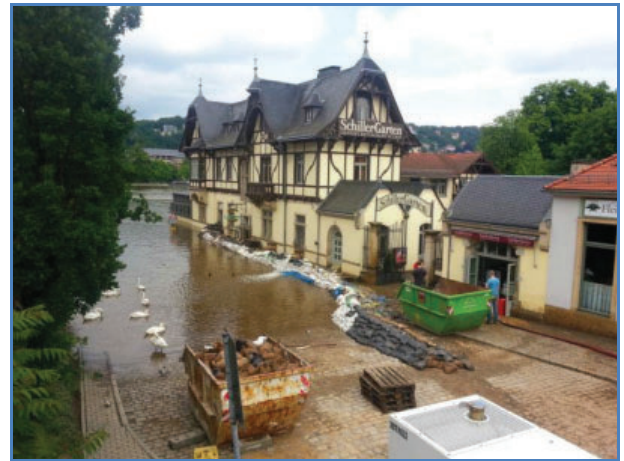
Abb. 10.3.2: Beginn des Rückbaus von Sandsackverbauen am Blauen Wunder (Quelle: Amt für Stadtgrün und Abfallwirtschaft der Landeshauptstadt Dresden)
