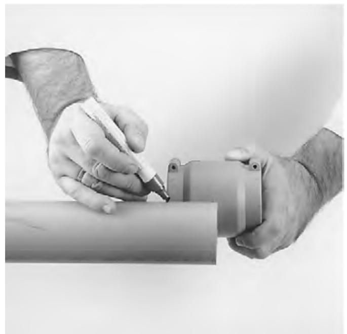
Stecken Sie die Rohre bis zur Markierung in das Formteil. Achten Sie darauf, dass die Rohre stirnseitig in der Mitte der Muffe zusammenstossen. Ziehen Sie die Schrauben der integrierten Rohrfixierung abwechselnd fest an.
