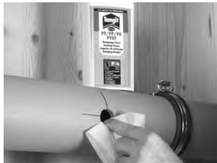
Reinigen Sie das Rohres und die Bohrung mit Tangit KS-Reiniger, Art.-Nr. 799 298 023. Entfernen Sie die Reinigungsflüssigkeit restlos mit dem Reinigungspapier.
