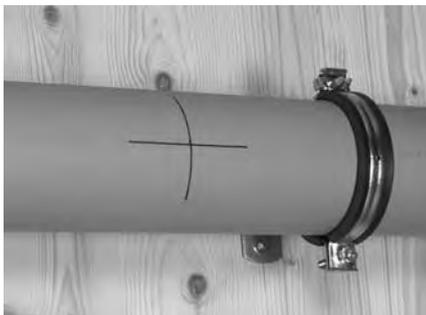
Markieren Sie die Bohrstelle.
