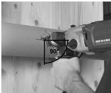
Durchbohren Sie die Rohrwand mit dem Bohrer-Code: 761 068 033. Benutzen Sie eine drehzahlgeregelte Bohrmaschine mit 300–350 U/Min.
