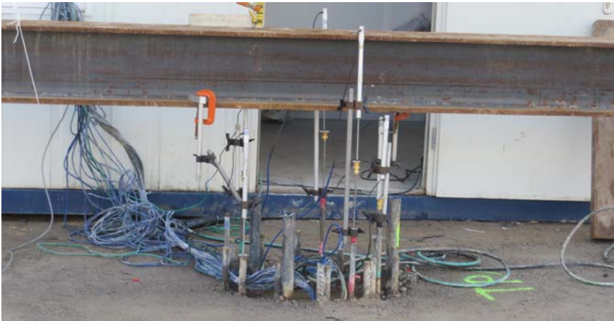
Versuchseinrichtung Pfahlbelastungsversuch mit Osterberg-Zelle
