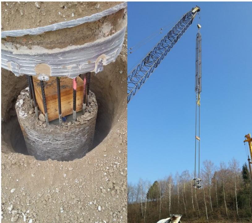
*Links: Durch Überbohrung entstandener Hohlraum vor Verfüllung mit Bentonit (Mantelreibungsausschluss auf obersten 10m).*
