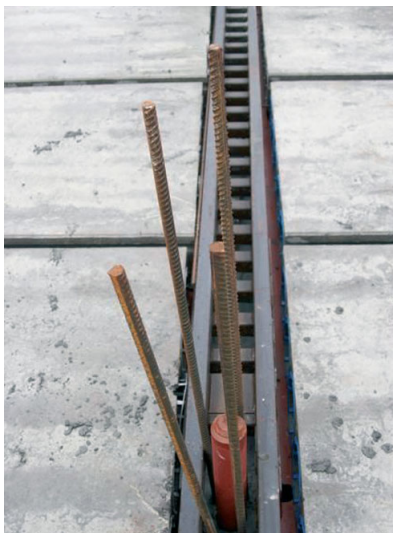
Bild 3. Deckenauflagerung auf SWT-Trägern im unvergossenen Zustand
