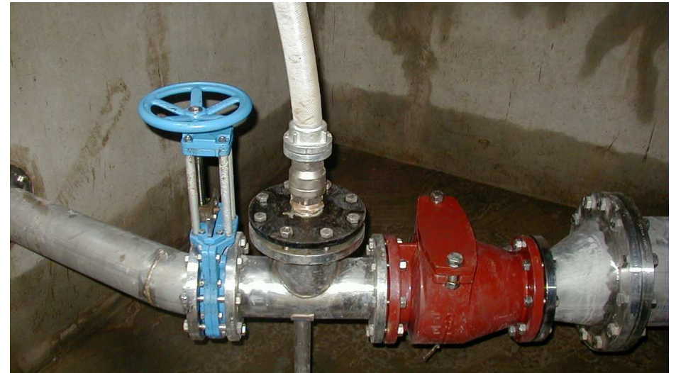
Adapteranschluss an BEV
