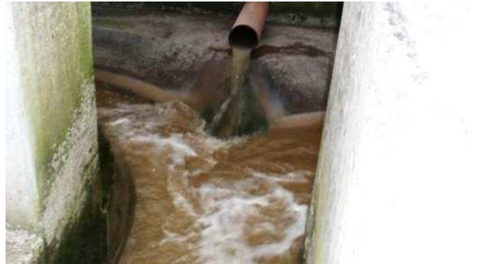
Ausspeisung in Kanal
