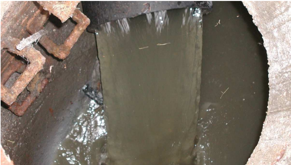
Ausspeisung in Schacht
