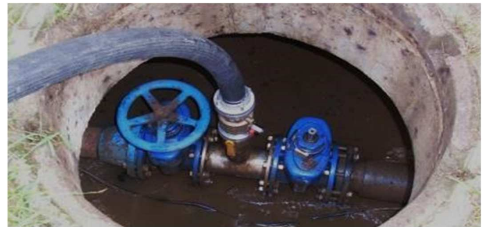
Adapteranschluss an BEV
