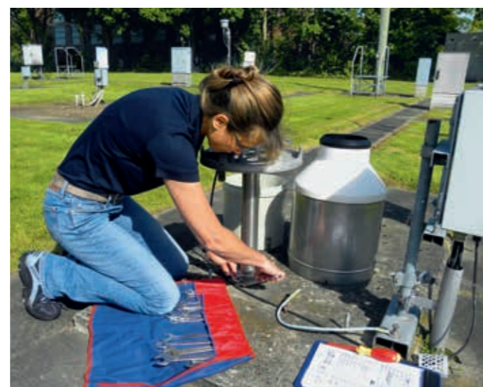
▼ Installationsarbeiten auf dem Testmessfeld in Hamburg-Sasel
