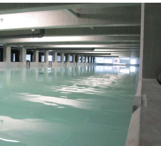
Bild 20: Fischzuchtbecken aus miteinander verklebten UHPC-Platten.
