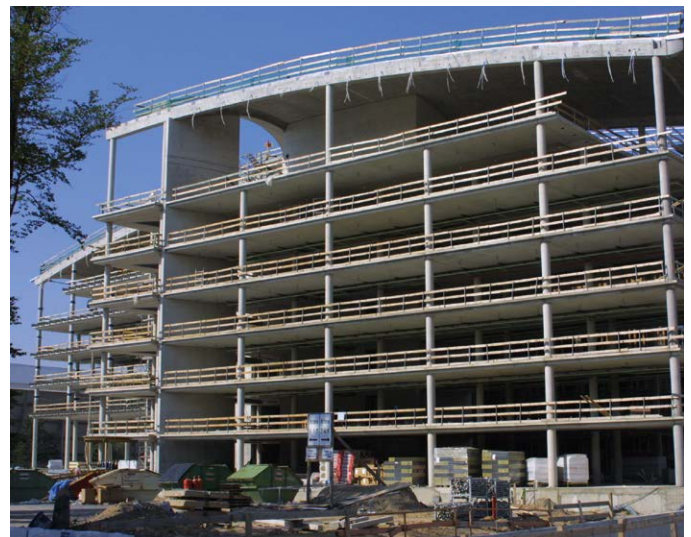
Bild 4: Stützenkonstruktion des Lufthansa Aviation Centers in Frankfurt
