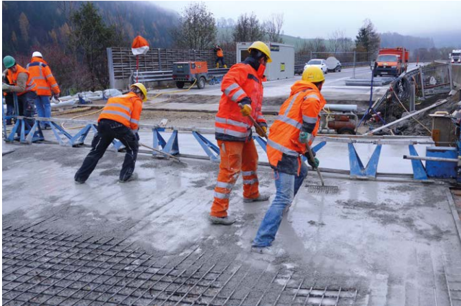
Bild 21: Arbeiten zur Brückenverstärkung mit UHPC an der Steinbachbrücke, Österreich
