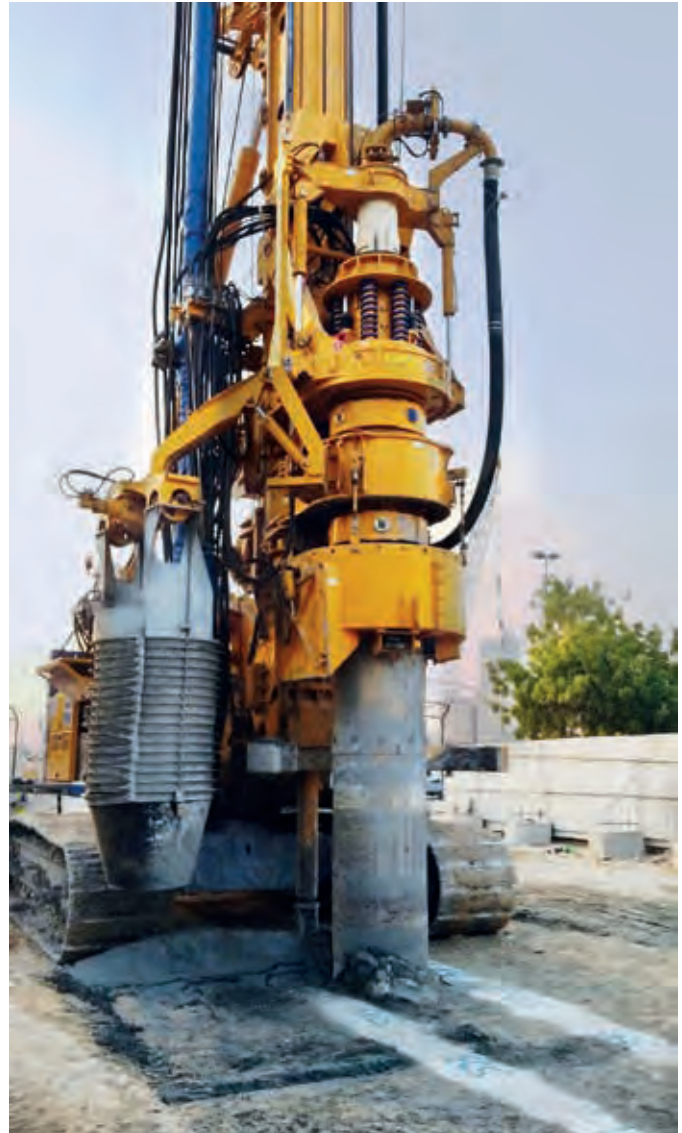
BG 39, CCFA mit BTM 400, Pfahlwand Dubai (VAE) BG 39, CCFA with BTM 400, Pile wall, Dubai (UAE)
