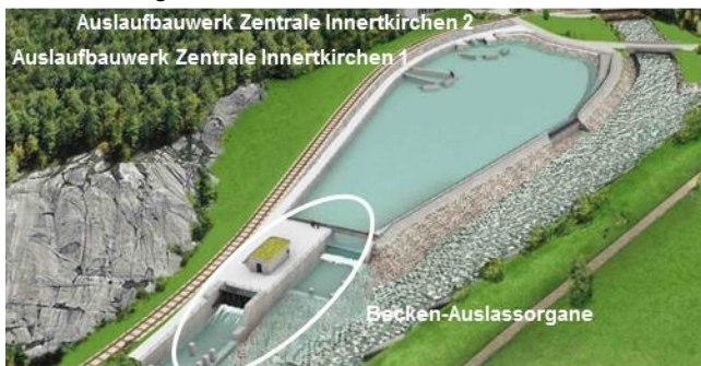
Abbildung 2 : Beruhigungsbecken für das Nutzwassers aus den Zentralen Innertkirchen 1 und 2 (Bild KWO)
