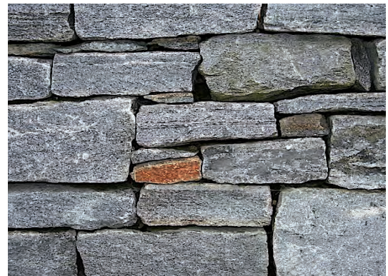
Mauer aus Gneis ohne Zement (Trockenmauer).
