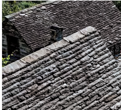
Neues Dach aus Gneis.
