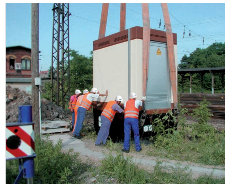
Eine Fertigteilstation wird an ihren Einsatzort gesetzt
