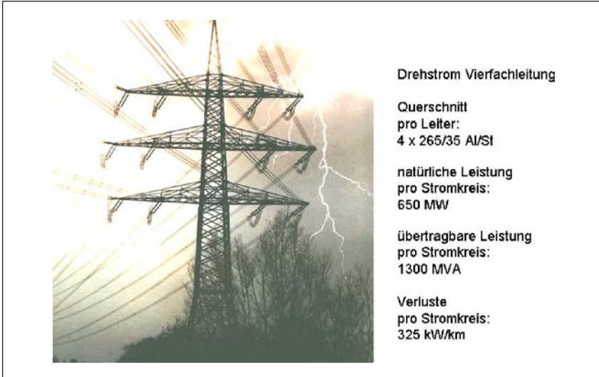
Abb. 6.2: Übertragungsfähigkeit von 400-kV-Drehstromleitungen
