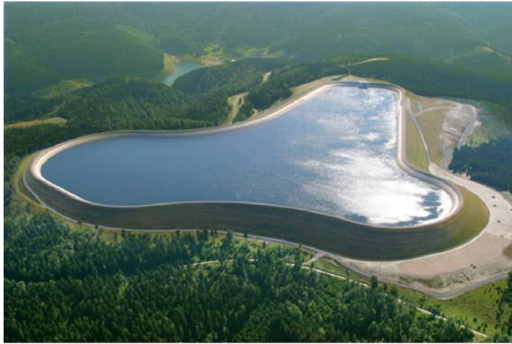
PSW Goldisthal: 1060 MW; 8480 MWh; Oberbecken: 12 Mio m 3
