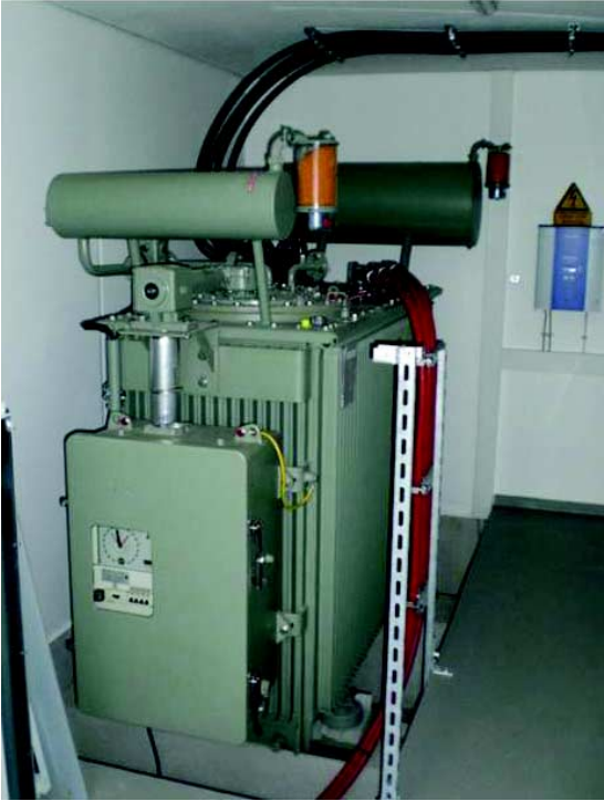
Abb. 6.2: Im Rahmen des Pilotprojektes eingesetzter SRONT (Hersteller: Siemens/MR)
