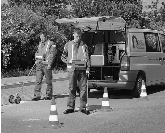
Abb. 10: Leitungsbegehung mittels Gasspürgerät (Quelle: DVGW)
