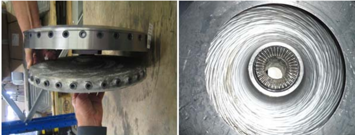
Abbildung 5: Aufnahmen über den Korrosionsschaden an der Sprühscheibe des Rotationszerstäubers [Quelle: AWG Wuppertal]
