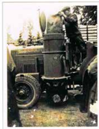
Holzgasgenerator wird mit Holzkohle beschickt.
