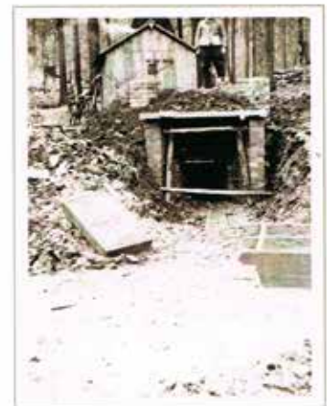
Beschickungsöffnung für das Holz, Entleerungsöffnung für die Holzkohle.
