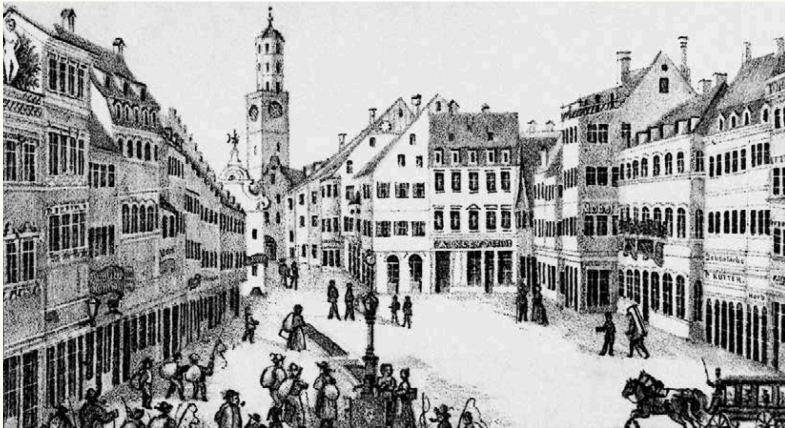
Zentrale Lage: Die Schönfärberei von Peter Kutter, rechts im Bild zu erkennen, lag mitten in Ravensburg in der Bachstraße.
