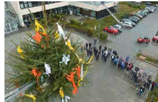
Wichtiger Bauabschnitt: Am 22. September 2015 konnte an der Baustelle des Weiterbildungszentrums in Weingarten Richtfest gefeiert werden.
