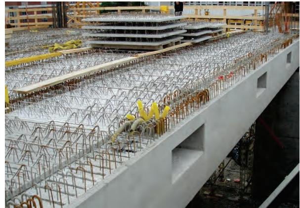
Bild 51: Elementdecken mit Halbfertigteilunterzug
