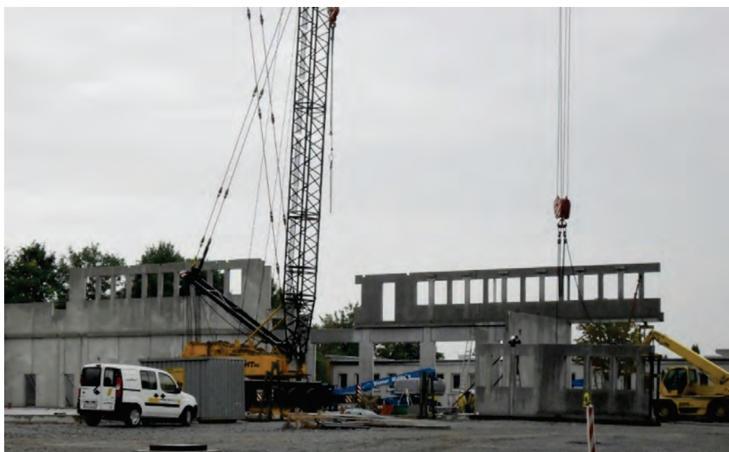
Bild 33: Raupenkran im Einsatz
