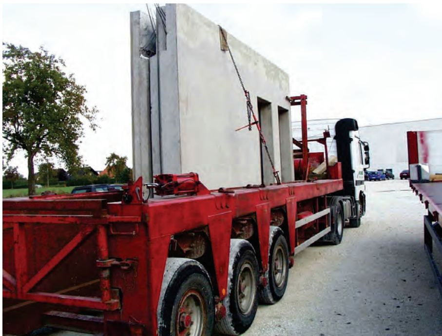
Bild 30: Transport von Wänden im Innenlader
