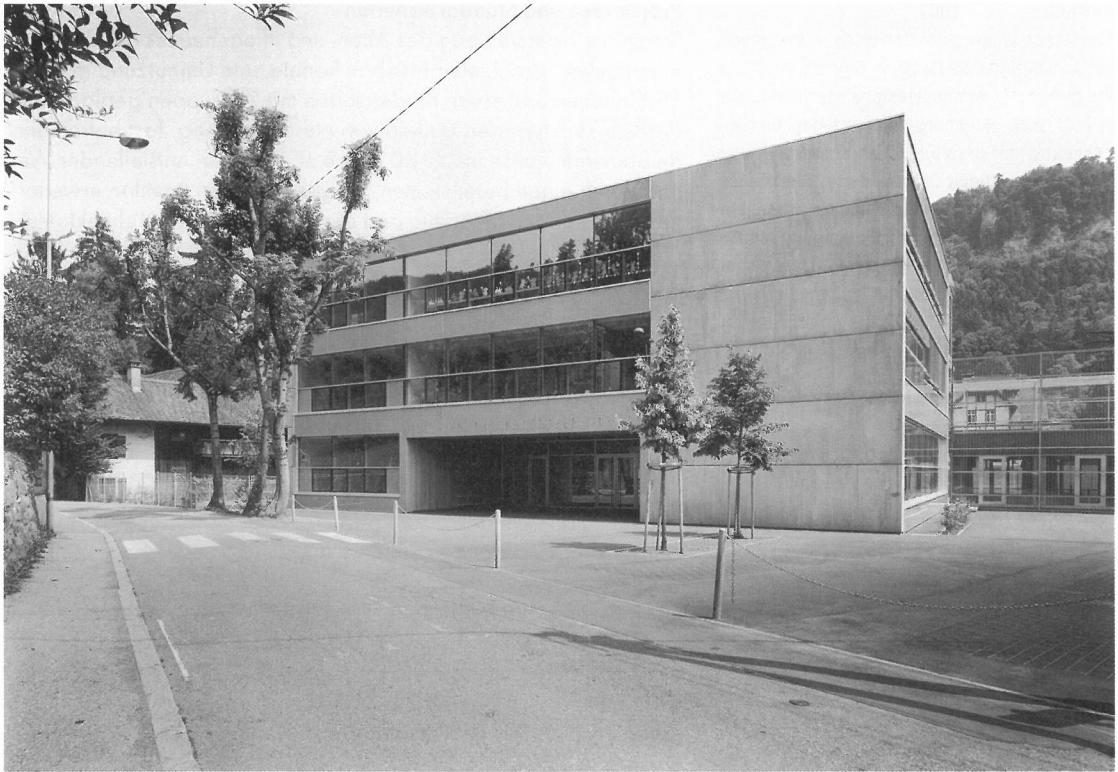
Zugangssituation Fidelisstraße: die Eingangsfassade öffnet sich zur ruhigen Nordwestseite
