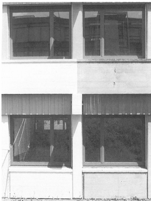
Probestück: Oberflächensanierung statt Einhausung
