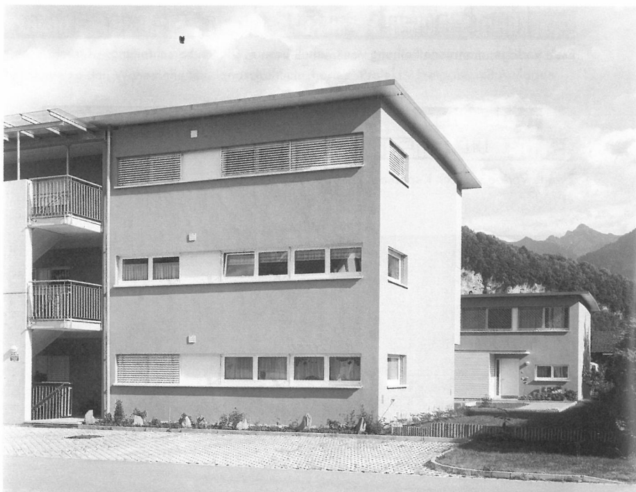
Richtige Variation der Bautypen: Geschosswohnungen an der Straße, Reihenhäuser im Hof
