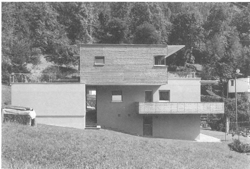
Zweite Vorlage: Dachaufsatz mit architektonischer Sorgfalt zurückgesetzt – Freigabe
