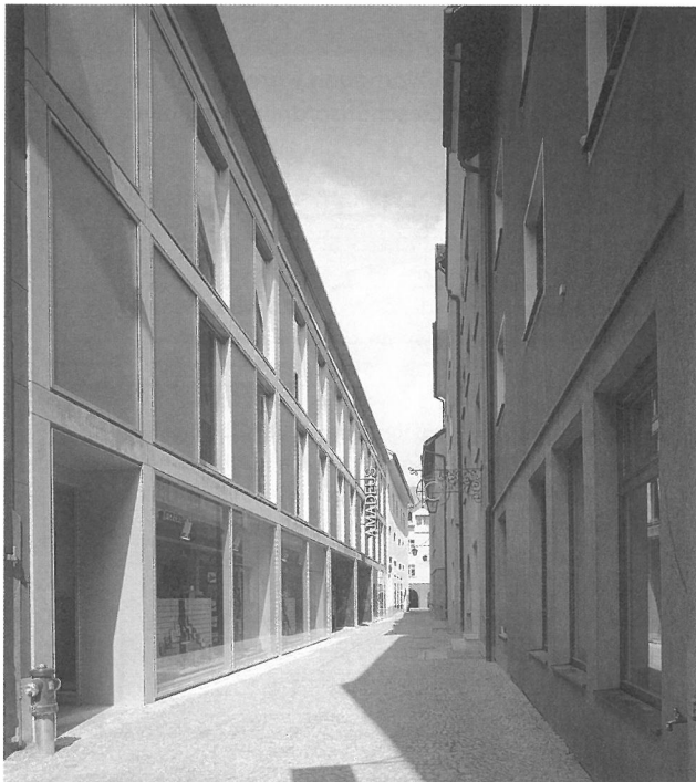
Fassade Zeughausgasse: gekonnte Materialaskese und Detaildisziplin
