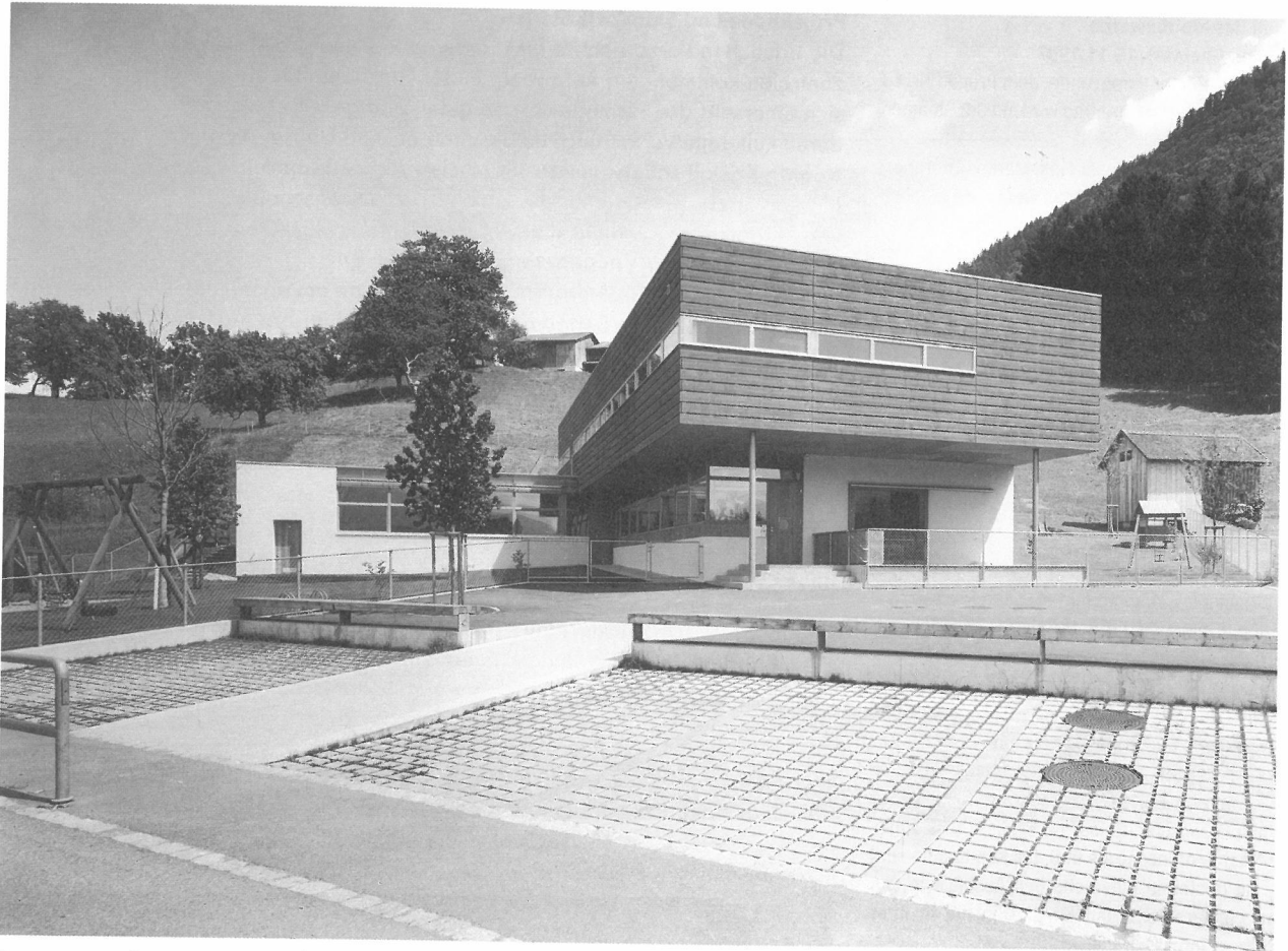
Angemessene Repräsentation: Beherrschung des Territoriums und zeitgemäße architektonische Mittel bei einem öffentlichen Bauwerk
