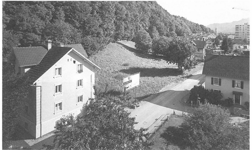
Am Hangfuß: zu dichte Erstvorlage sperrte Blick bergwärts ab – Zurückweisung
