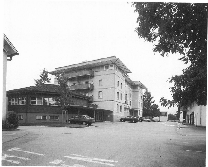
Differenz Stadt-Land: das von landwirtschaftlichen Gebäuden bestimmte, dörfliche Umfeld wird durch das urban nachgerüstete Wohnhaus kontrastiert
