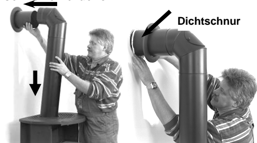
Abb. 8: Montage Rauchrohr
