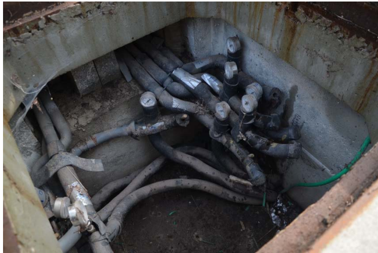
Abbildung 49: Erdwärmerohre – Verteilerschacht
