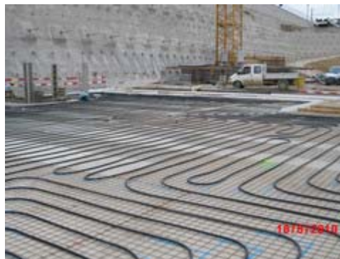
Abbildung 37: Verlegung der Absorberleitungen vor Errichtung der Bodenplatte, Quelle: ÖBB-Infrastruktur AG
