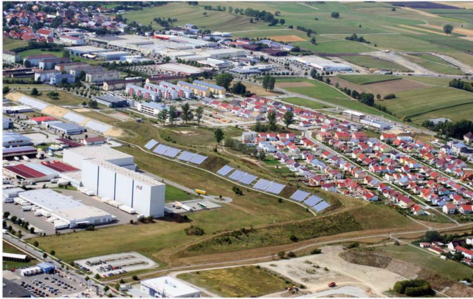
Solar Kollektoren auf Dächern und Lärmschutzwall sind ausgefallene Merkmale des solaren Nahwärmesystems in Crailsheim-Hirtenwiesen. Ein Ersonden-Wärmespeicher bevorratet solare Wärme für den Winter. © Stadwerke Crailsheim GmbH
