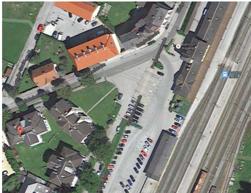
Abbildung 99: Luftbild - Bahnhofsgelände Aspang Markt
