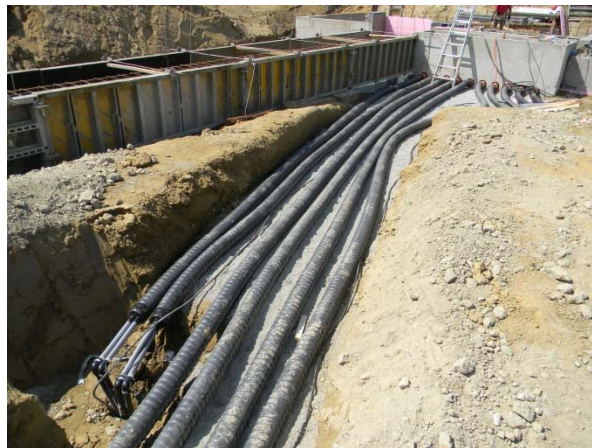
Abbildung 16: Bau eines Erdwärmesondenfeldes (Fotos: G.Domberger)
