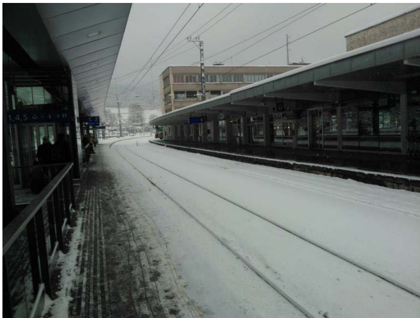
Abbildung 65: Bahnsteige im Bahnhof Leoben – Winter
