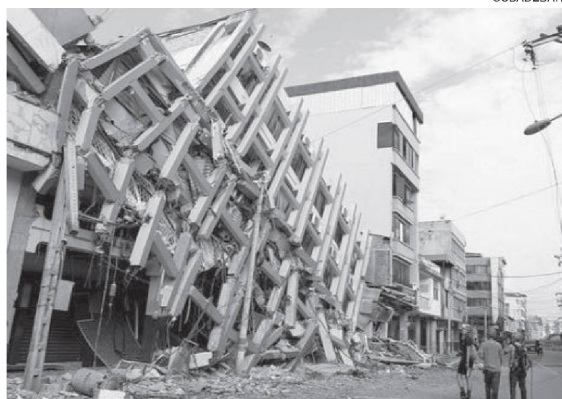
Zerstörungen in Portoviejo
