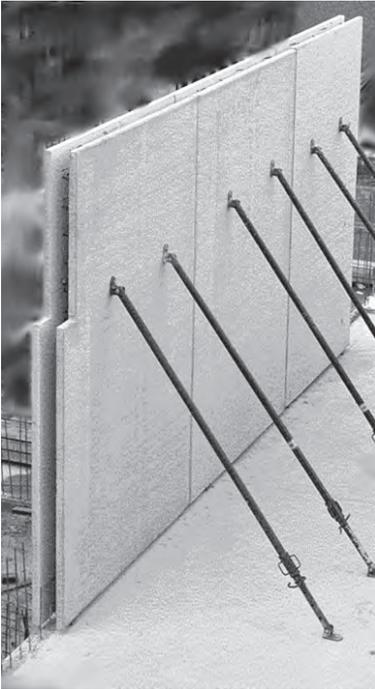
**Bild 3.** Elementwand mit Gitterträgern im Montagezustand
