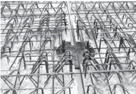
**Bild 107.** Stützenbereich einer Elementdecke mit noch offener Druckfuge
