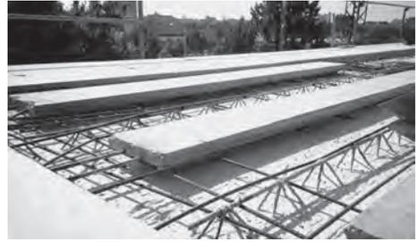
**Bild 53.** Gitterträger mit Betonobergurt nach [82] in der Anwendung
