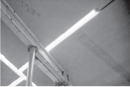
**Bild 105.** Elementfugen zur Ausführung als Druckfuge
