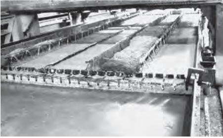
**Bild 48.** Betonieren einer „Höckerdecke“ nach [80]
