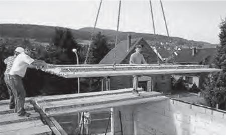
**Bild 52.** Unterstützungsfreie Montage einer Höckerdecke nach [80]
