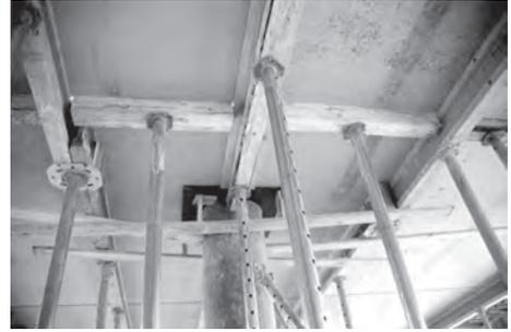
**Bild 106.** Abgeschaltete Druckfugen einer Elementdecke
