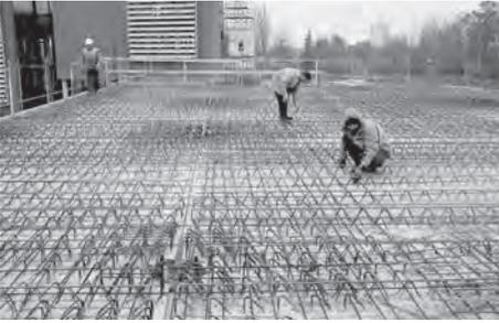
**Bild 55.** Einbau durchlaufender Querbewehrung auf den Fertigteilplatten
