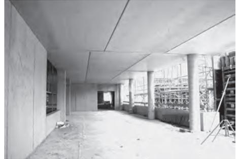
**Bild 4.** Elementdecke als Flachdecke (Deckenuntersicht)
