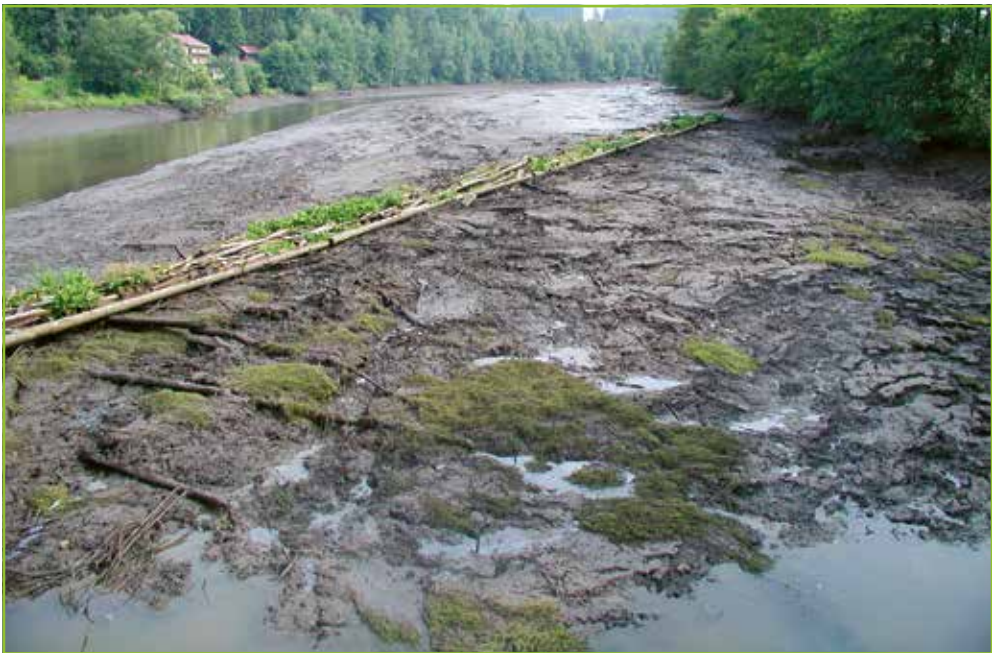
Abbildung 7-28: Der Stausee Regen weist massive Schlamm- und Feinteilablagerungen auf, die in abgesenktem Zustand sichtbar werden.
