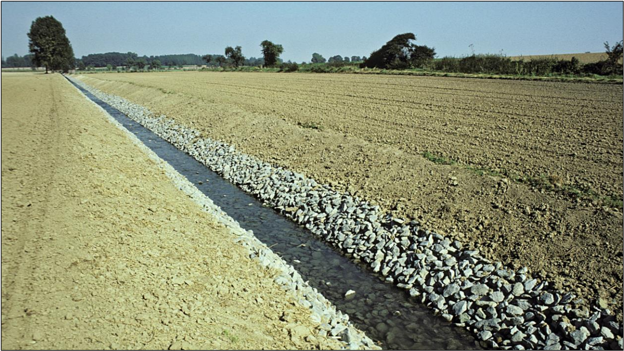
Bis in die 1980er Jahre wurden bei uns Bäche begradigt und zu Vorflutern ausgebaut.
