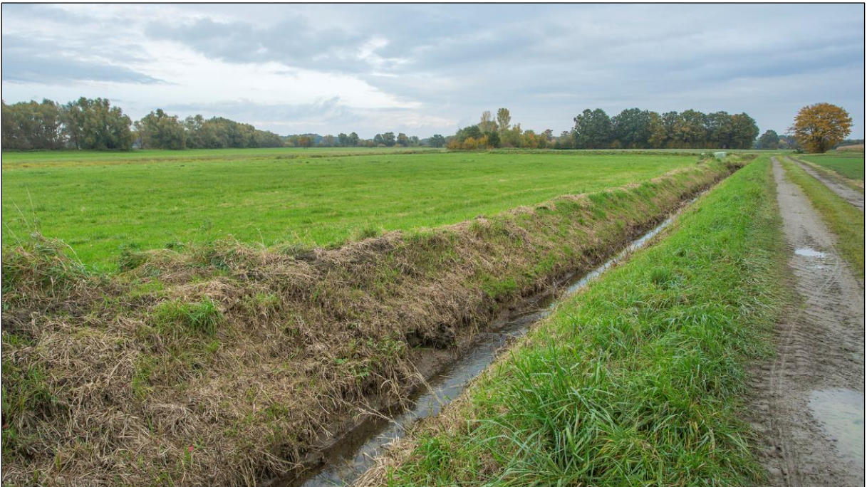
Für Entwässerungsgräben wie dieser in der Lippeaue ist die ausgebaute, künstlich eingetieft Lippe der Vorfluter.
