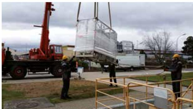
Abbildung 2: Einbringung der neuen Reinstwasseranlage in den Betrieb (Quelle der Abbildungen 2 und 3: der Autor mit freundlicher Genehmigung der Warner Chilcott Deutschland GmbH).
