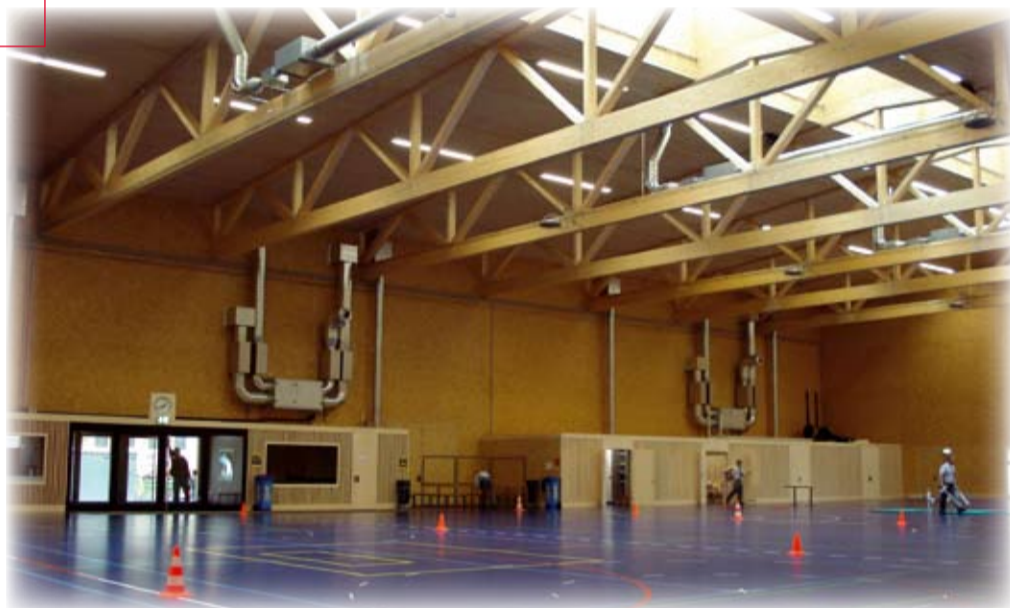
Die neue Minergie-P-Dreifachturnhalle: eine logistische Meisterleistung
