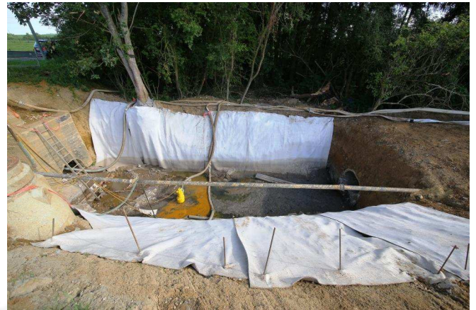
Baustellenansicht: keine weitere Erosion erkennbar
