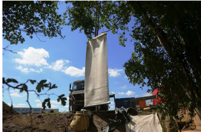
Baustellenansicht: Verlegung mit LKW - Kran
