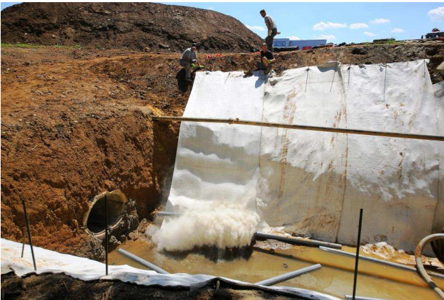
Baustellenansicht: Rollenlängen passend geliefert
