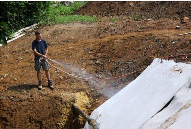
Baustellenansicht: Aktivierung mit Wasser
