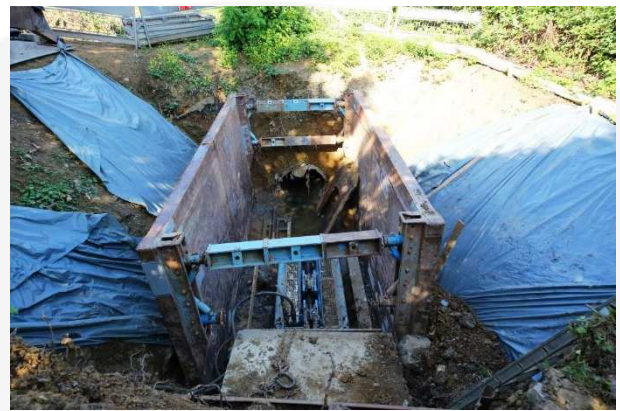
Baugrubensicherung mit Folie und Verbau
