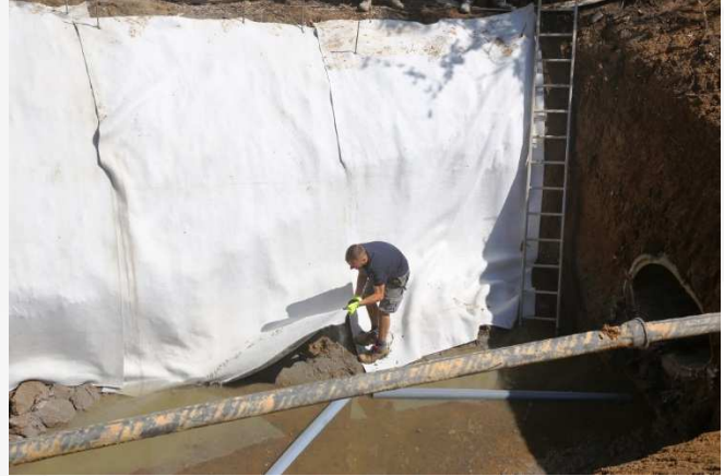
BVR 9000: einfache Verlegung, leichtes korrigieren der Überlappung
