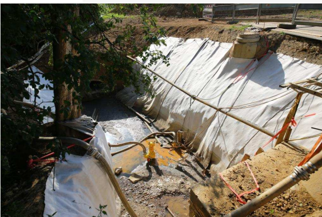
Baustellenansicht: nach Installation keine weitere Erosion nach gefluteter Baugrube
