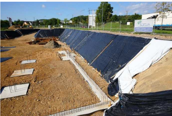
Baugrubensicherung mit Folie und Holzverlattung
