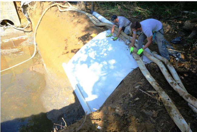
BVR 9000: einfaches händisches Verlegen, Fixierung mit Erdnägeln
