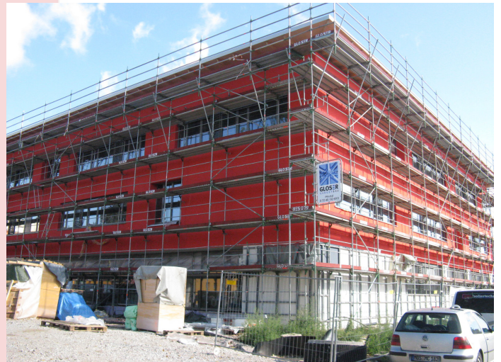
Abb. 4: Passivhausbau (Quelle: Hochbauamt FFM)
