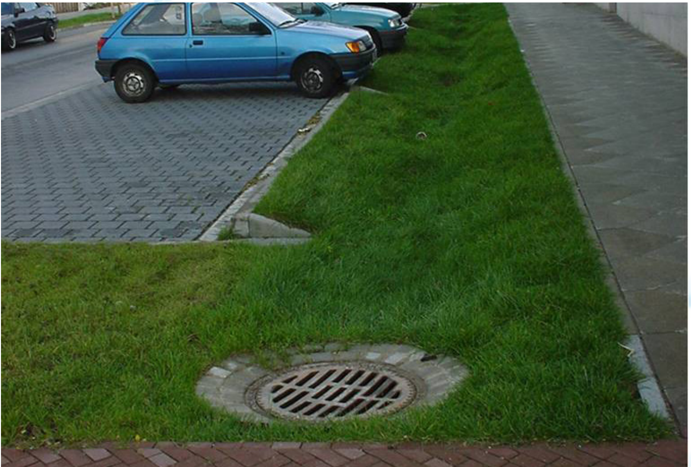
Abb. 12: Mulden-Rigolen-System im Baugebiet Hannover-Kronsberg (Quelle: Stadtentwässerung FFM)
