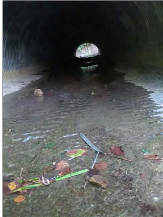
Abb. 8, 9: bestehender Bachdurchlass Hofmattweg mit Maulprofil aus Wellstahl (Sicht bachabwärts)
