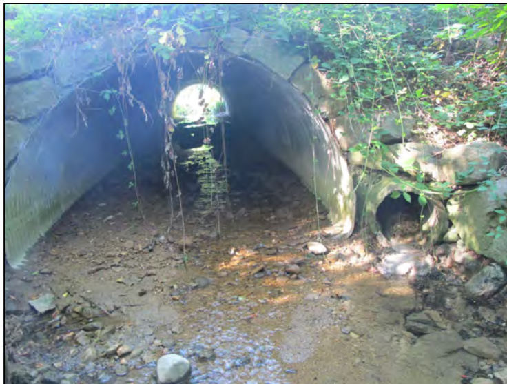
Abb. 10: bestehender Bachdurchlass Hofmattweg (Sicht bachaufwärts)
