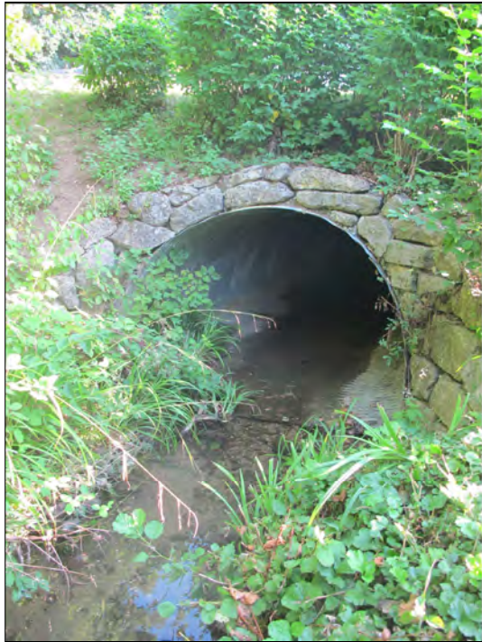
Abb. 8, 9: bestehender Bachdurchlass Hofmattweg mit Maulprofil aus Wellstahl (Sicht bachabwärts)
