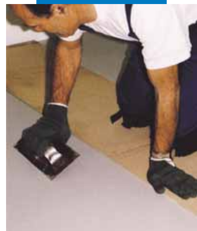
Anreiben des Belages; zur Vermeidung von Eindruckstellen ist eine stabile Hartfaserplatte untergelegt
