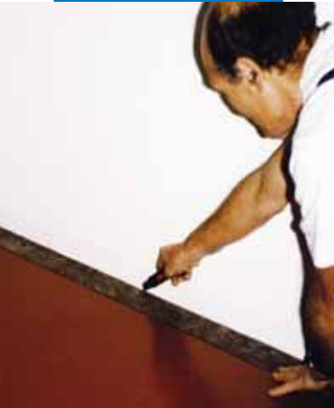
Verlegung von Mapelay mit einer Wandanschlussfuge von 5-10 mm
