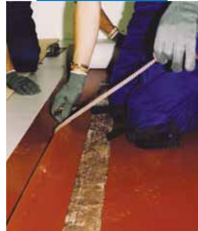
Entfernen der abgeschnittenen Mapelay-Kante
