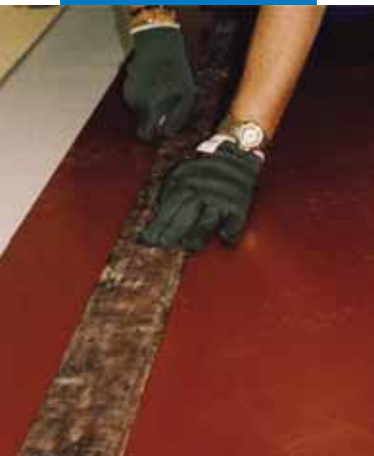
Nahtschnitt bei Mapelay
