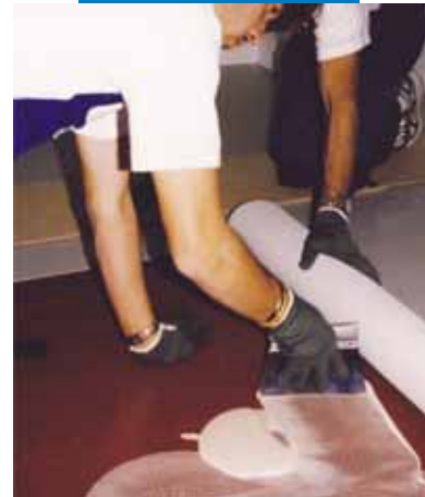
Verlegung eines Gummi-Belages auf Mapelay mit Adesilex G19 . N.B. Die Fugen des Belages müssen zur Fuge der Mapelay-Bahnen einen Versatz von 10-20 cm aufweisen
