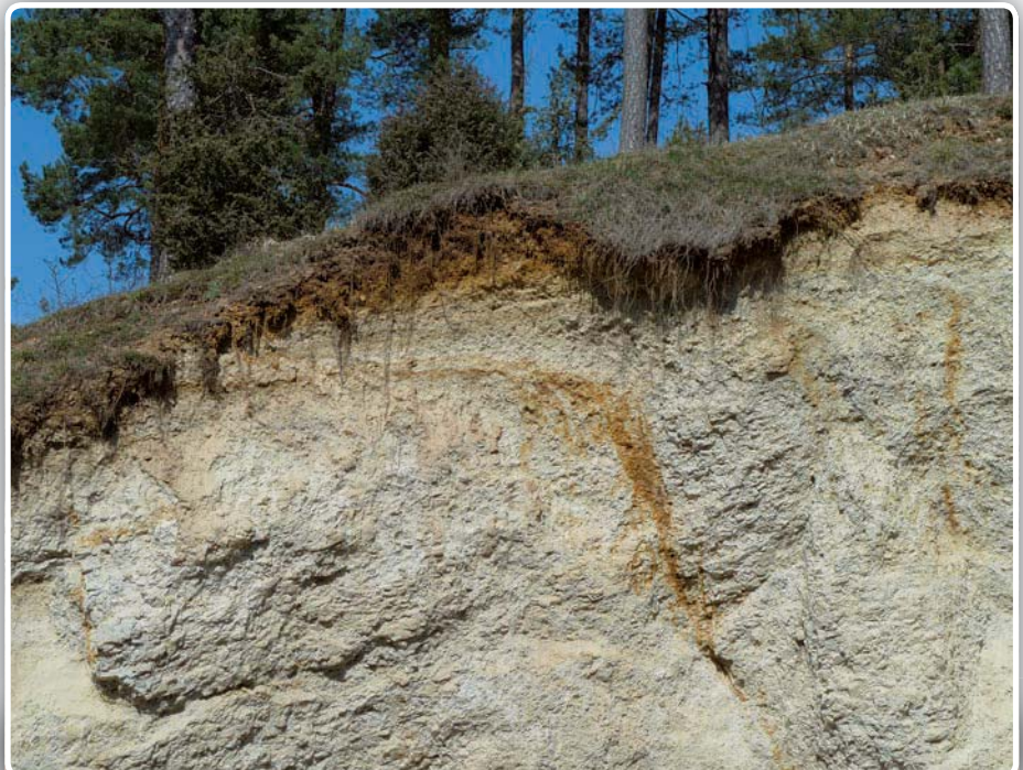
Bild 5 Grube im Dolomitgrus nördlich Haßlach (Foto: 03.04.2012).
