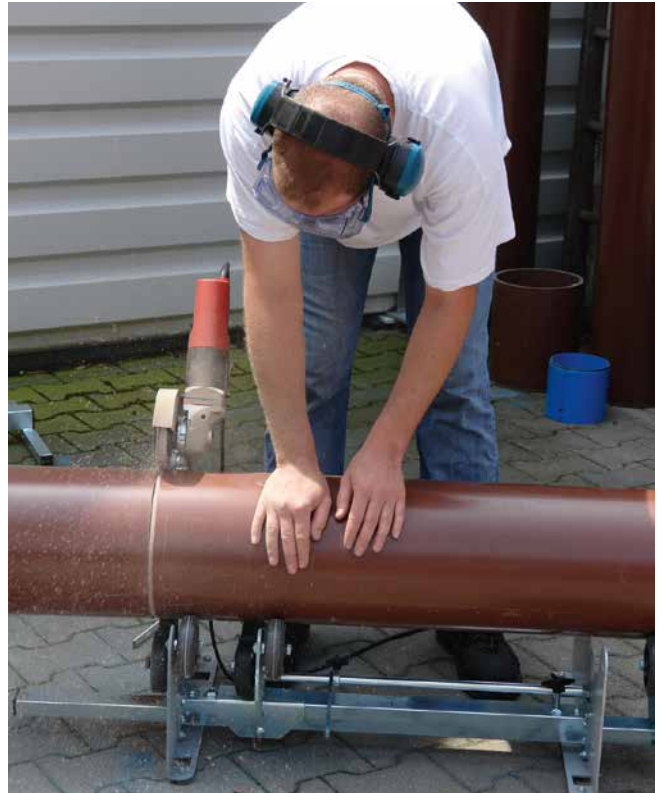
Sicheres Ablängen und gleichzeitiges Anfasen der Hausanschlussrohre
