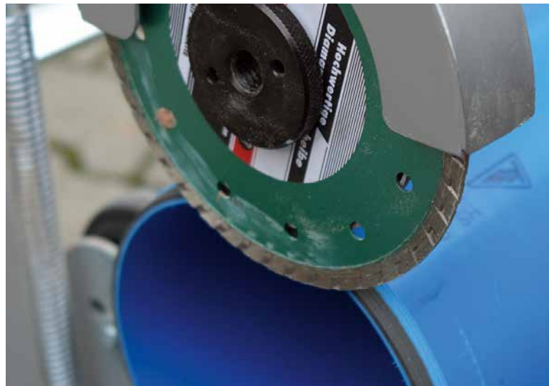
Anfasen des Rohres
