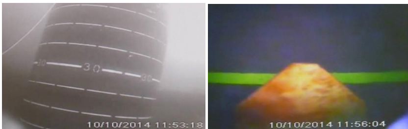
Abbildung 11: Monitoring der Rammung durch UW Kameras
