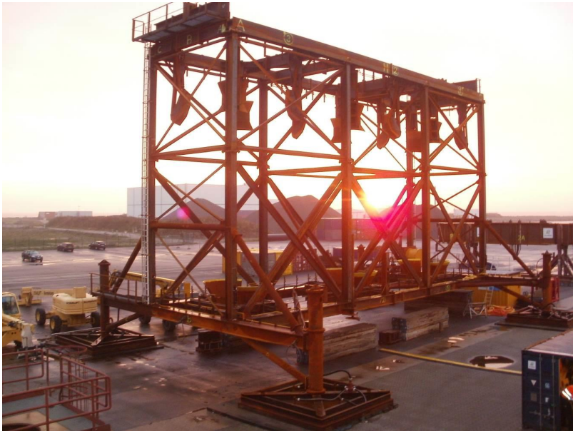
Abbildung 4: Rammschablone im Basishafen Sassnitz
