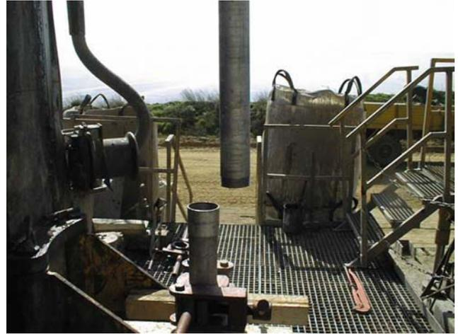
Abb. 8 Einbau der 4" Pegelrohre
