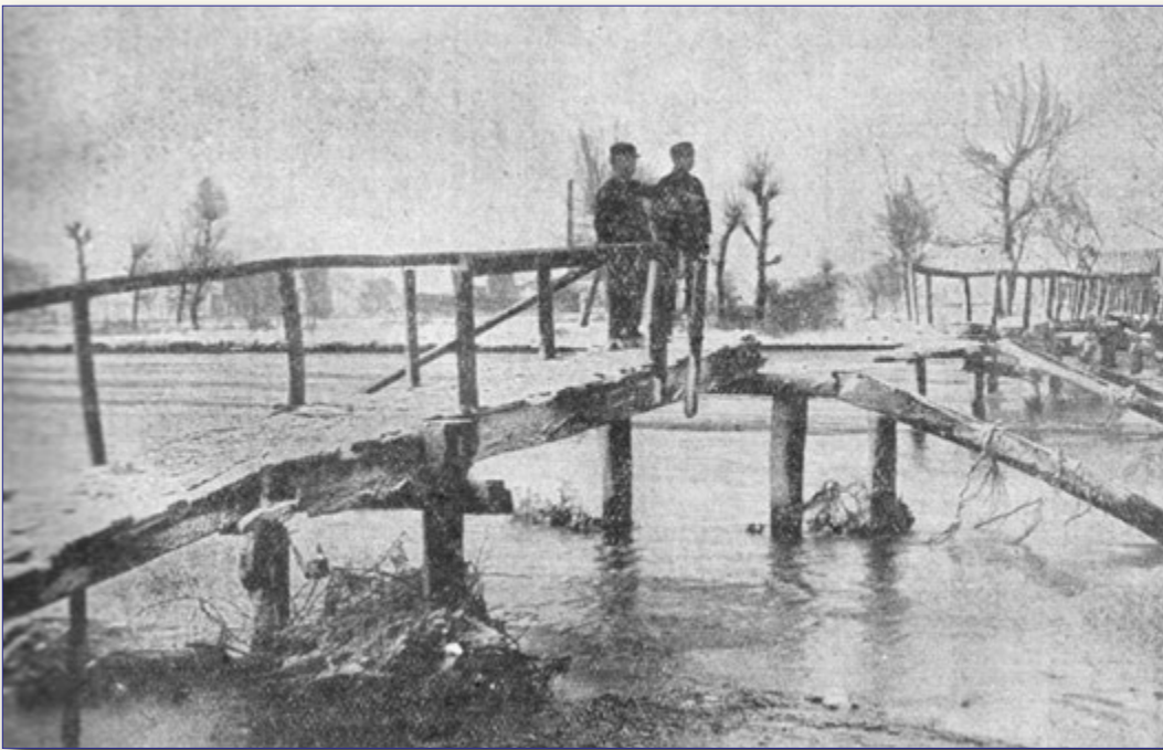
1893 wurde ein Teil des Franzosenstegs infolge treibender Eisschollen fortgerissen Quelle: Heimatblätter, Beilage zur Dürener Zeitung 03/1936
