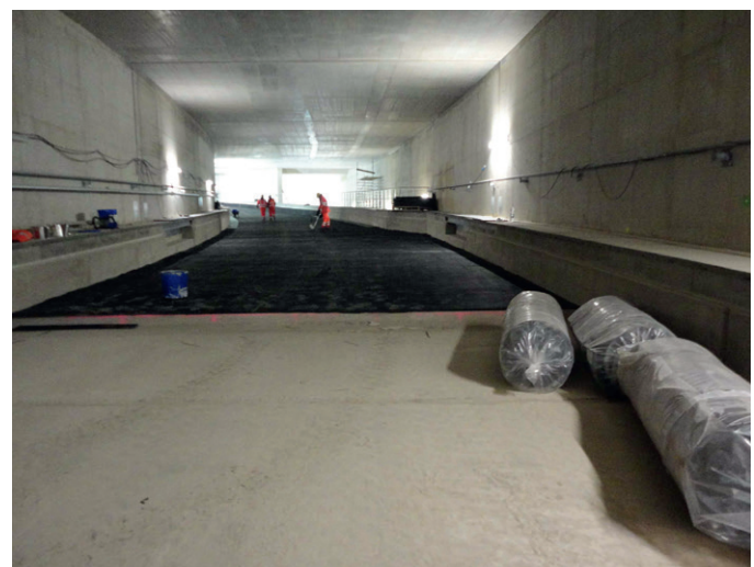
Abb. 3: Einbau der Unterschottermatten.
