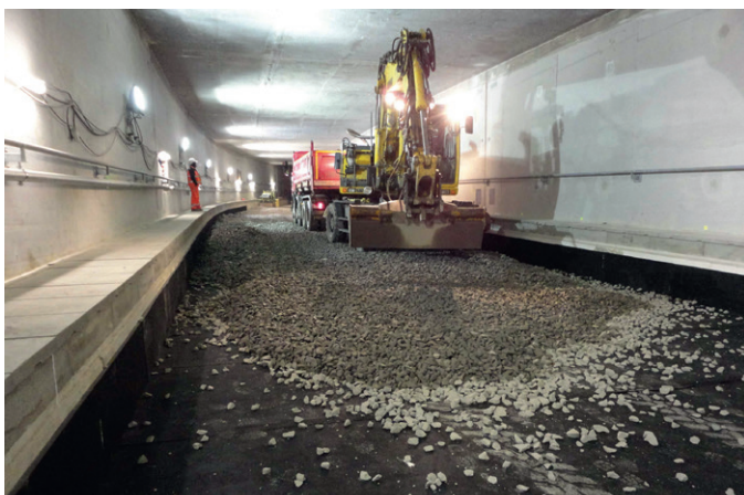
Abb. 4-10: Arbeitsschritte zum Einbau von Unterschottermatten.
