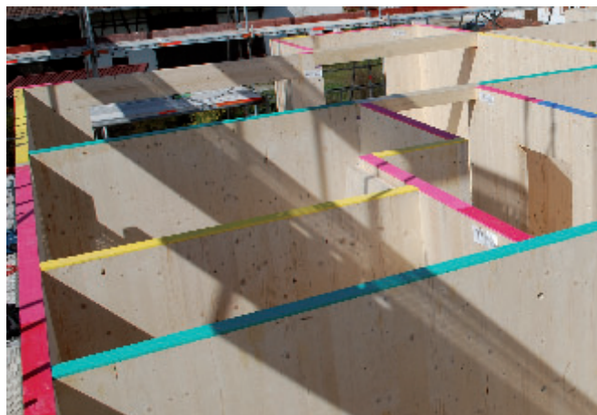
Bild 1. Elastische Zwischenlagen auf CLT-Wänden mit unterschiedlichen Steifigkeiten (Getzner Werkstoffe GmbH)
