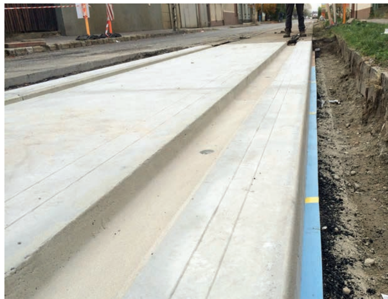
Abb. 4: Gleistragplatten mit Schienenkanal
