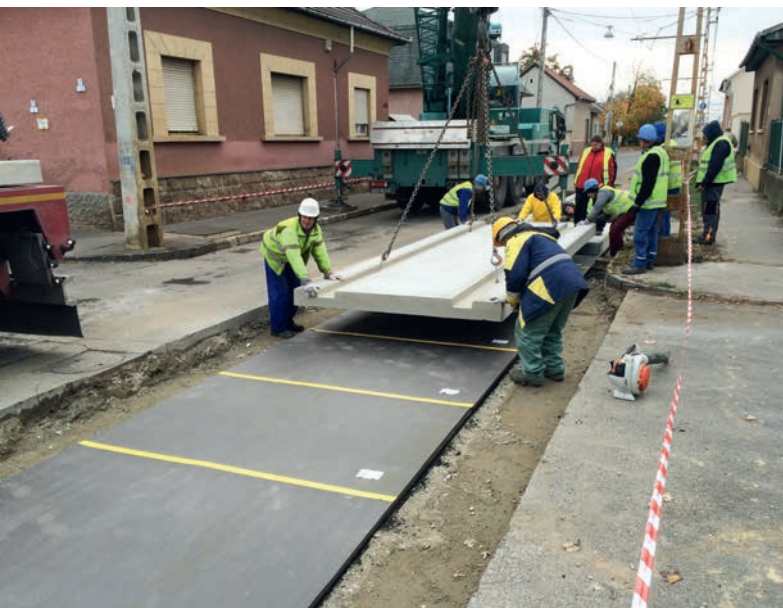
Abb. 3: Einheben der Gleistragplatte
