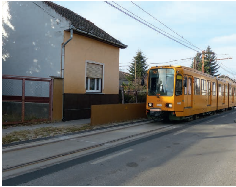
Abb. 6: Straßenbahn T6000 bei der Überfahrt über das neue MFS
