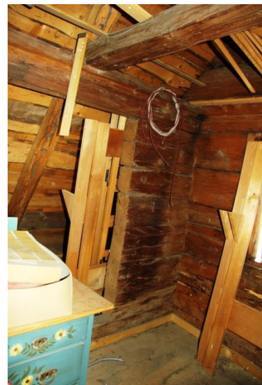
Abb. 16: Blick in das Dachwerk mit Stummelwand.
