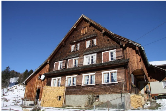
Abb. 13: Südfassade. Blickrichtung Nord.
