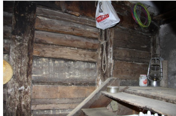
Abb. 14: Westliches Treppenhaus, Ständerwand mit Fleckling-Ausfuchungen, Blickrichtung Nordwest.
