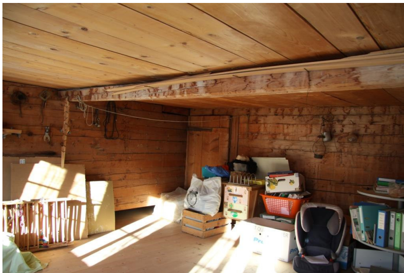
Abb. 15: Kammer im Obergeschoss, mit allenfalls bauzeitlicher Tür, Brettertür mit eingeschobenem Leisten und Langband. Blickrichtung Nordwest.
