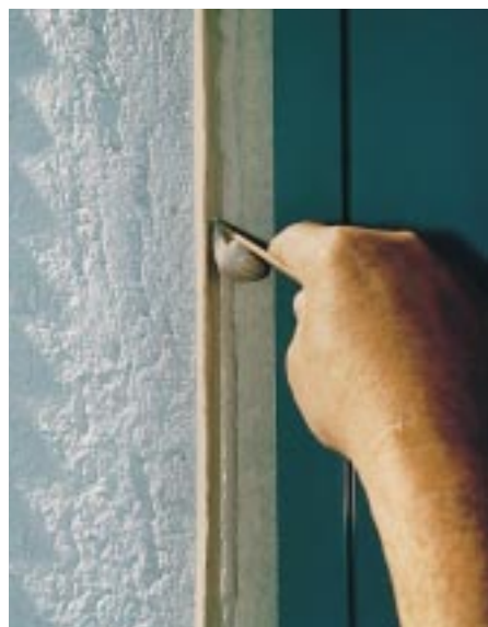
Bild 7: Glätten des Dichtstoffs mit geeignetem Werkzeug vor Beginn der Hautbildung
