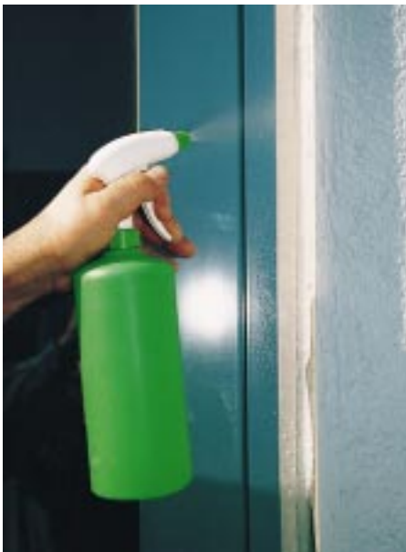
Bild 6: Glättmittel aufsprühen auf den frisch verarbeiteten Dichtstoff
