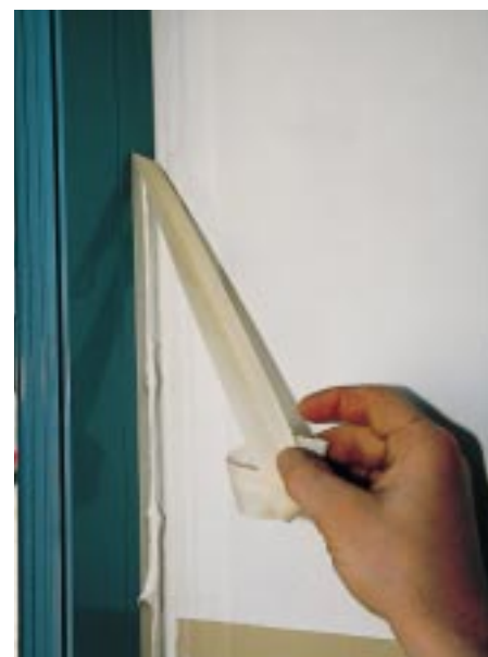
Bild 8: Entfernen der Selbstklebebänder – diese wurden zum Schutz der Fugenränder vor Verunreinigungen vor der Verarbeitung des Dichtstoffs aufgeklebt – sofort nach dem Glätten
