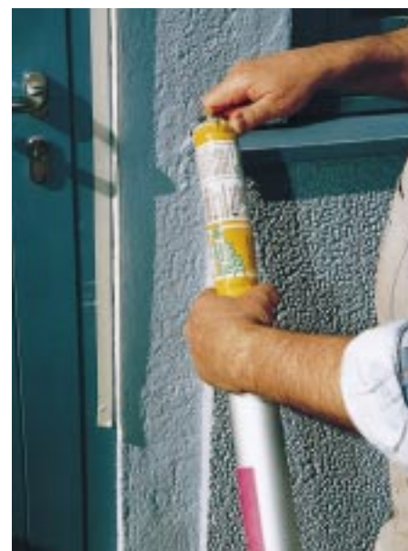
Bild 2: Einführen des Schlauchs mit ein-komponentigem Polyurethan-Dichtstoff „PCI-Elritan 100“ in die Spritze und Abschneiden am Clip
