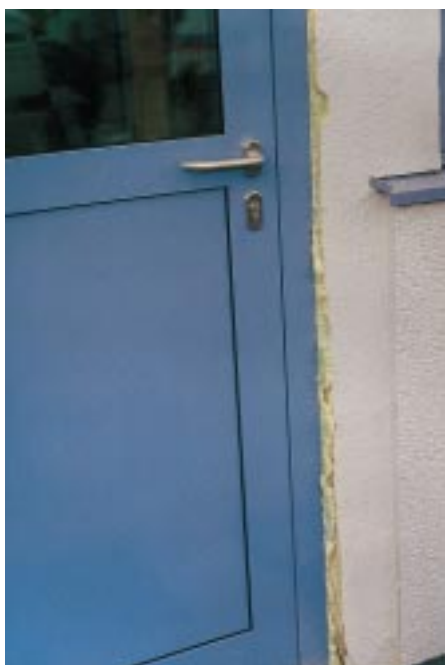
Bild 1: Einsatz eines schon mit Montage-Schaum fixiertem Türprofils beim Erneuern einer Außentür an einem Kantinegebäude
