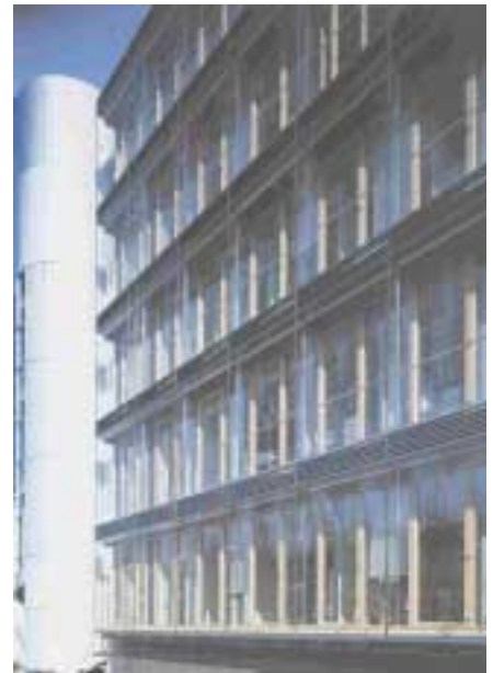
Bild 2: Holz-Alu-Doppelfassade der Firma Schindler, Roding, für die Hauptverwaltung der AOK in Stuttgart
