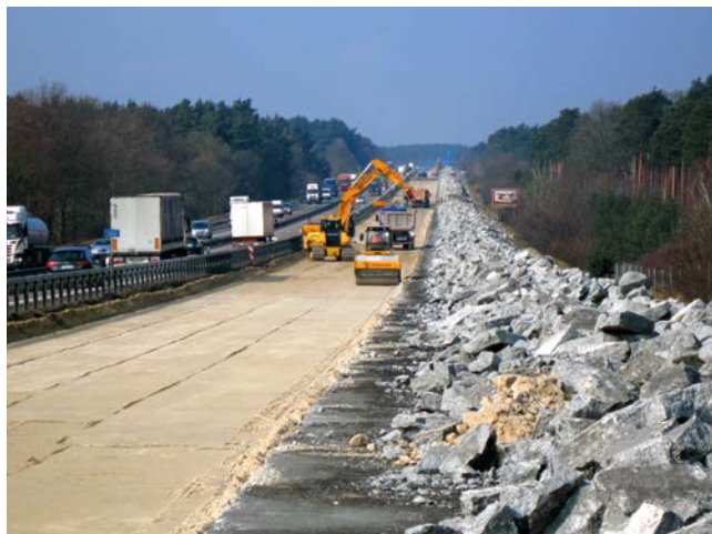
Bild 10: Aufbruchgut halbseitig gelagert
