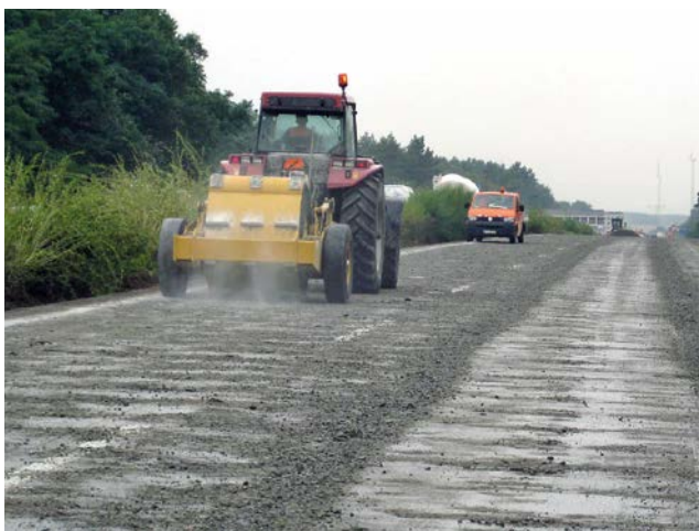
Bild 5: Aufbruch mit Würfelwalze
