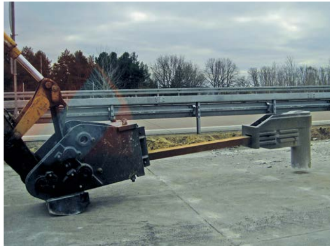
Bild 8: Erschütterungsarmer Aufbruch durch Power Sledge
