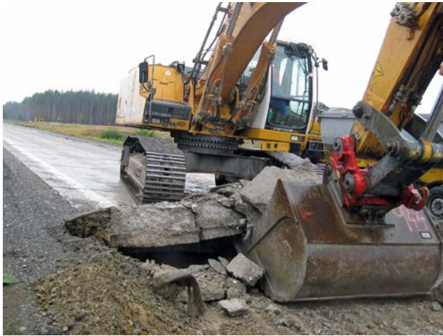
Bild 2: Sowohl an Beton als auch an HGT anhaftendes Vlies
