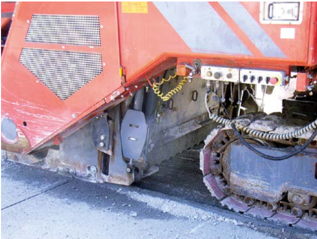
Bild 7: Aufbruch durch Fräse
