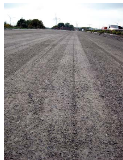
Bild 11: Schottertragschicht mit Spuren des Baustellenverkehrs
