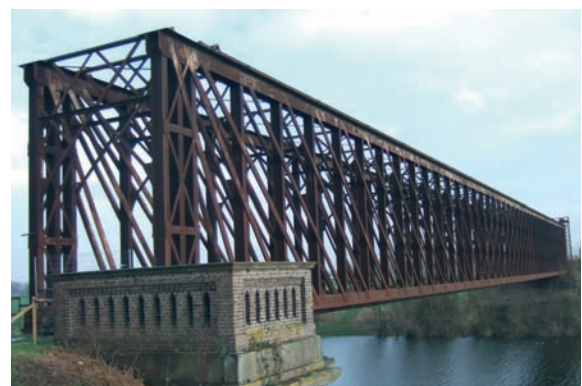
2 Griethausener Eisenbahnbrücke bei Kleve
