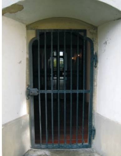
2 Gittertür aus Profilen
