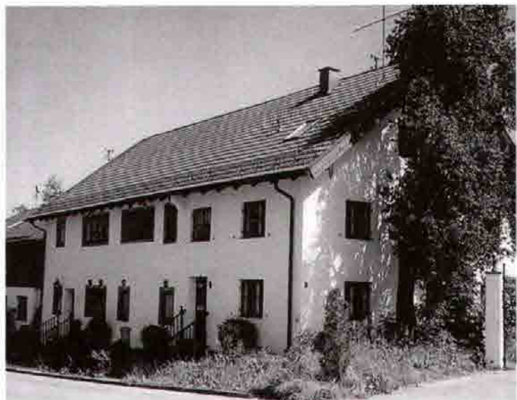
Controller-„Schulhaus“ Ettersschlag, vgl. Bericht S. 219 ff.
