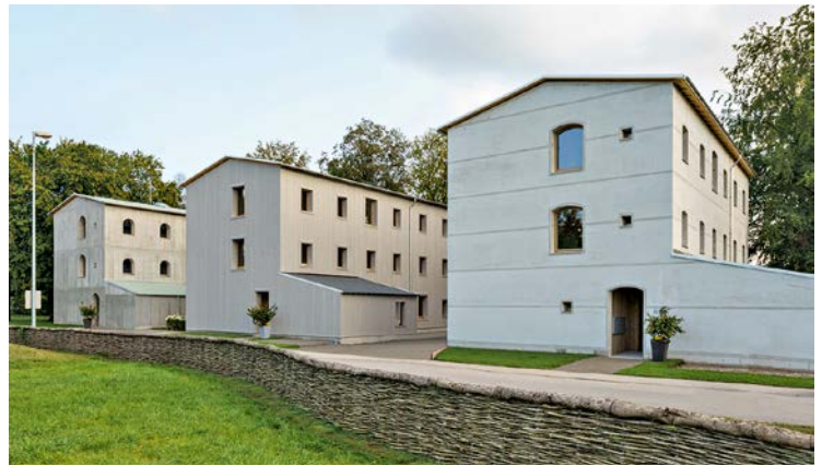
Die drei Forschungshäuser auf dem B&O-Parkgelände in Bad Aibling wurden im Rahmen des Forschungsprojekts „Einfach Bauen. Ganzheitliche Strategien für energieeffizientes, einfaches Bauen“ errichtet, das die Wechselwirkung von Raum, Technik, Material und Konstruktion untersucht
