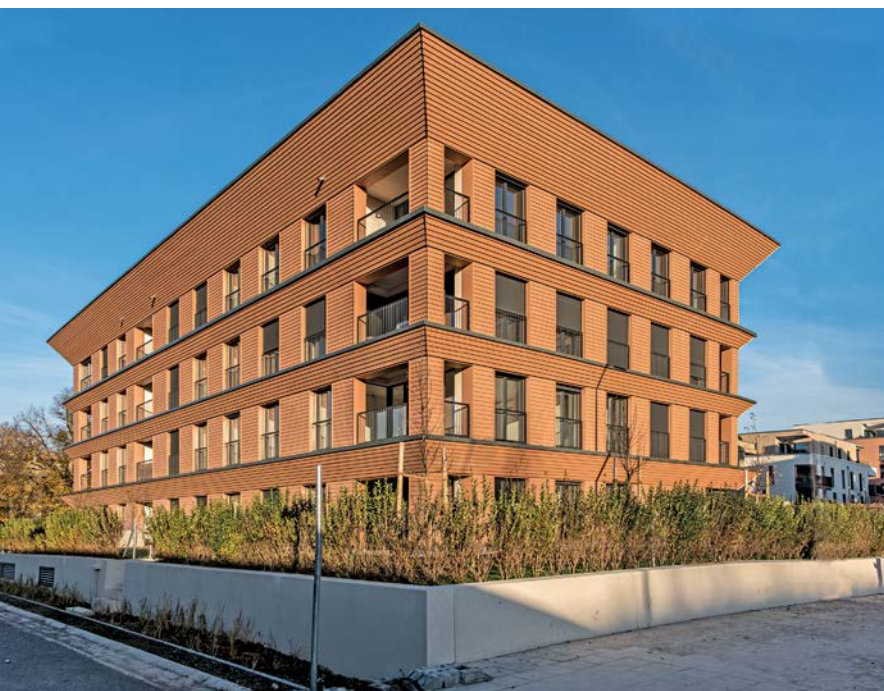
Ein Beispiel für den modernen Wohnungsbau in Holz-Hybrid-Bauweise steht in München: die Werkwohnungen am Domagpark
