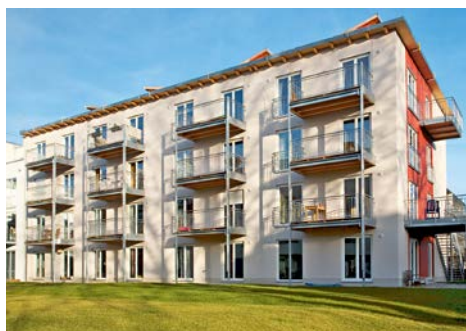
Das „Vogelnest“ im Freiburger Stadtteil Vauban war 2007 einer der ersten viergeschossigen Holzbauten. Der Bau wurde durch ein gesundheitliches Qualitätsmanagement begleitet
