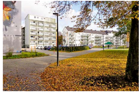
Hell, freundlich, übersichtlich: 2019 wurde die Sanierung des Quartiers Lütgenholz abgeschlossen
