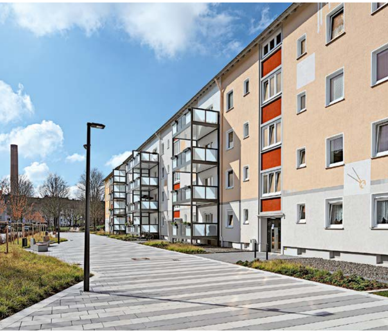
Dank einer grundlegenden Umgestaltung von Außenanlagen und Fassaden hat sich das Sicherheitsgefühl der Anwohner signifikant verbessert. Auch die neuen Balkone tragen zum erhöhten Sicherheitsempfinden bei
