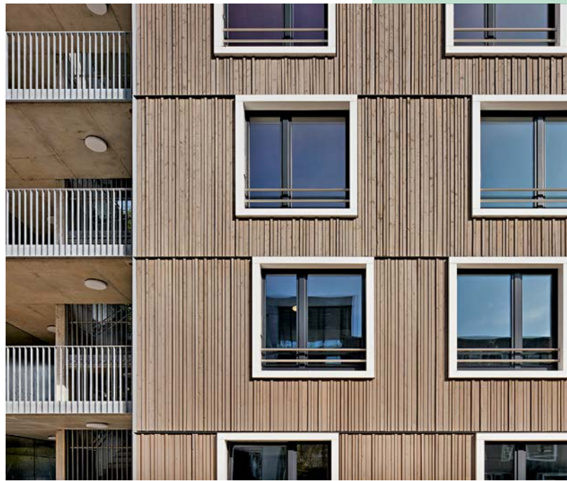
Detailaufnahme der Holzfassade. Die Montage der Elemente erfolgte ohne Gerüst
