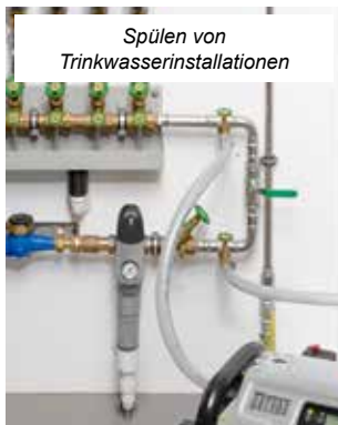
Desinfizieren von Trinkwasserinstallationen
