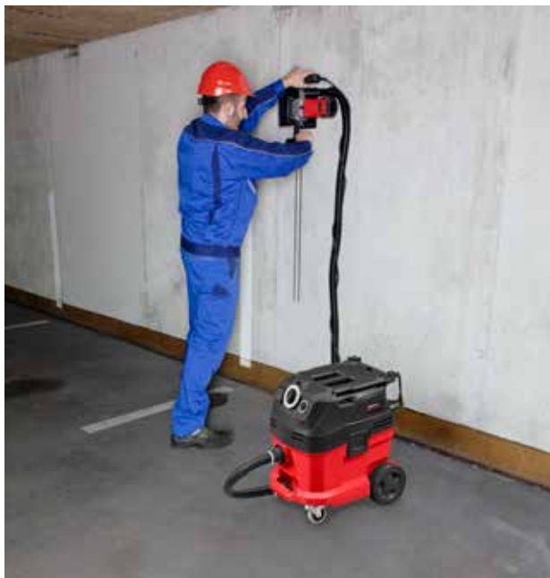
Saugen von gesundheitsgefährdenden Stäuben beim Trennen und Schlitzzen
