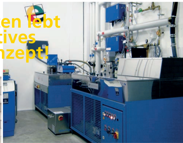
die zentrale Wasseraufbereitungsanlage
