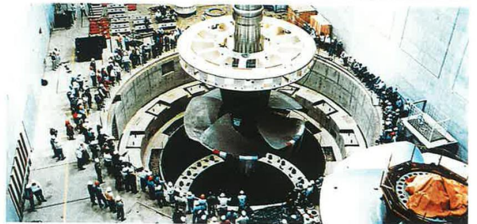
Laufradmontage im Kraftwerk.
