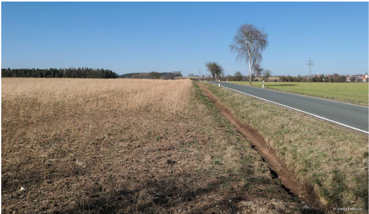
Abbildung 22: Blick entlang der GVS mit Jahrsdorf im Hintergrund
